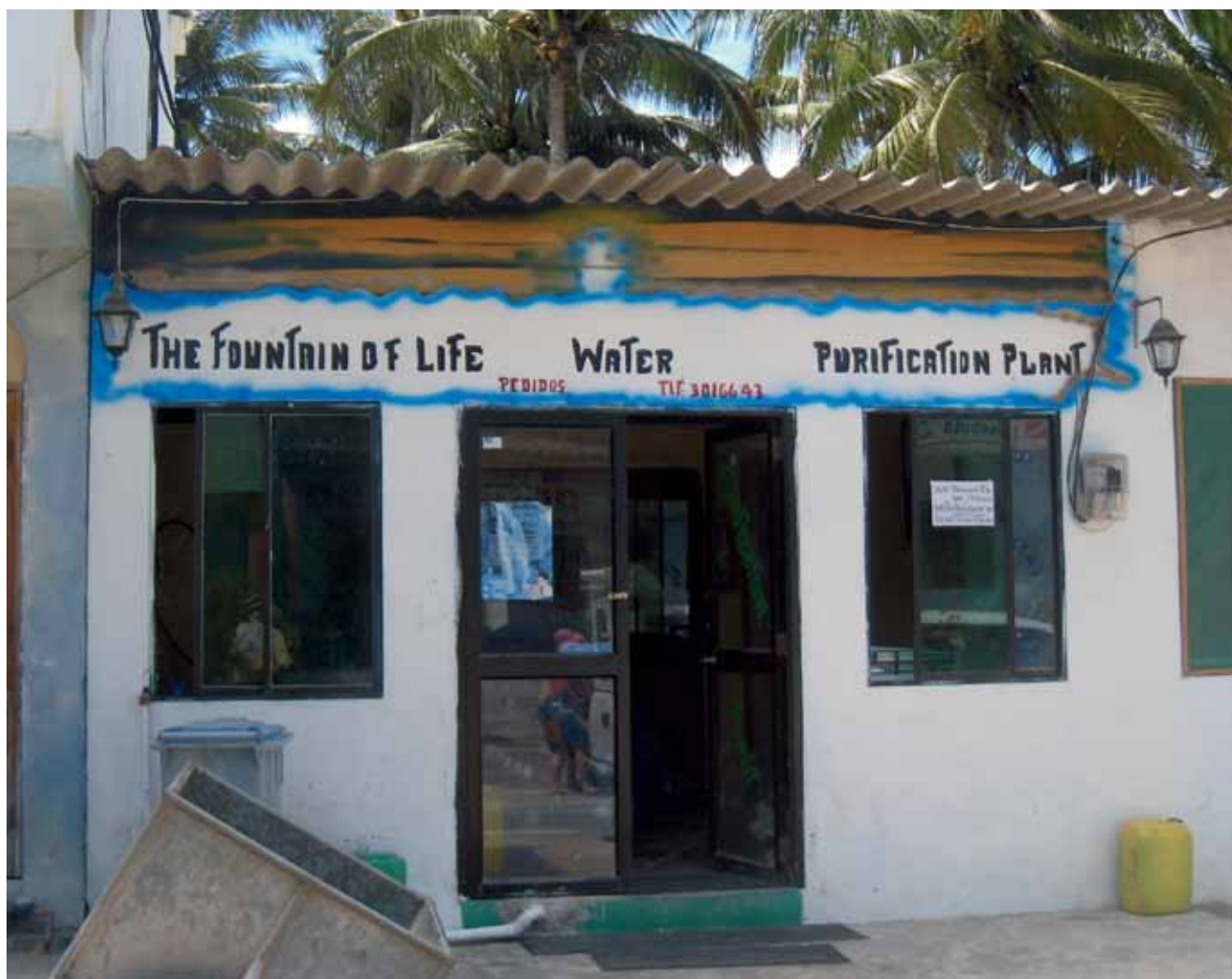
Figura 9. Planta purificadora de agua. Foto: Josselin Guyot-Tephany
